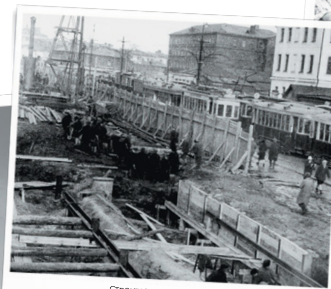
Строительство метро, 1933 год
